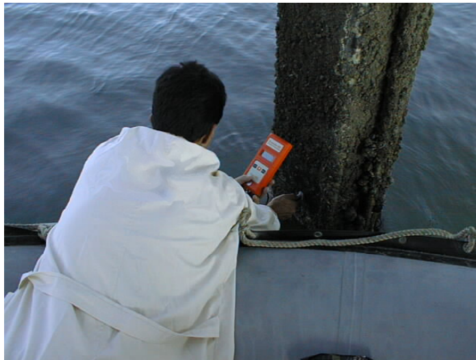
Fig. 1 - Aparelho de ultra-sons para medição da espessura de elementos metálicos.
